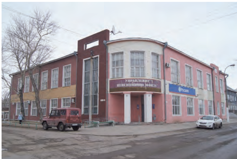
г. Славгород ул. Володарского, 145. Памятник архитектуры Банк Общий вид
